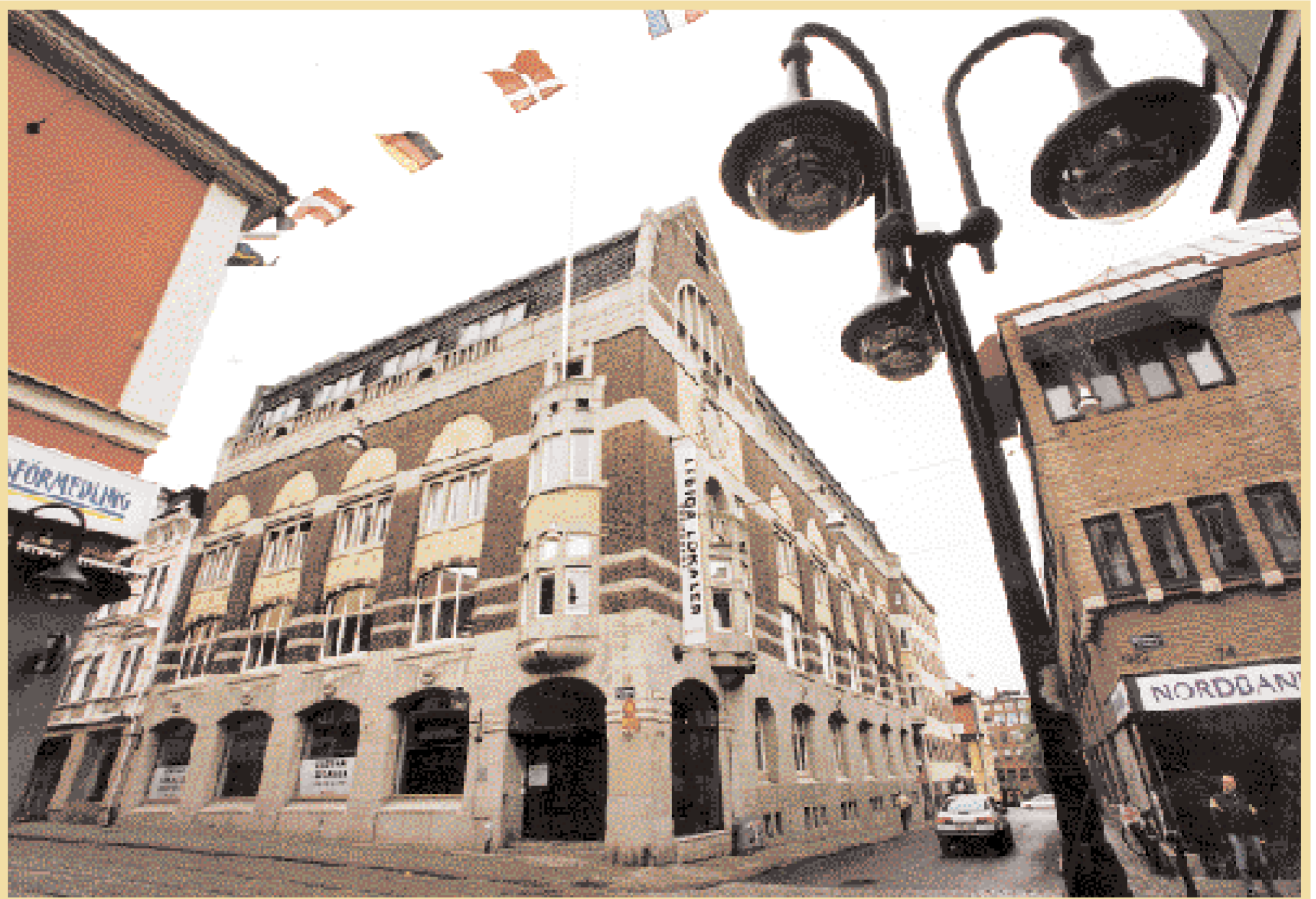
Aron Johansson Teleborg längs Drottninggatan stod färdig år 1912. Byggnaden är uppförd i jugend och nationalromantisk stil.
