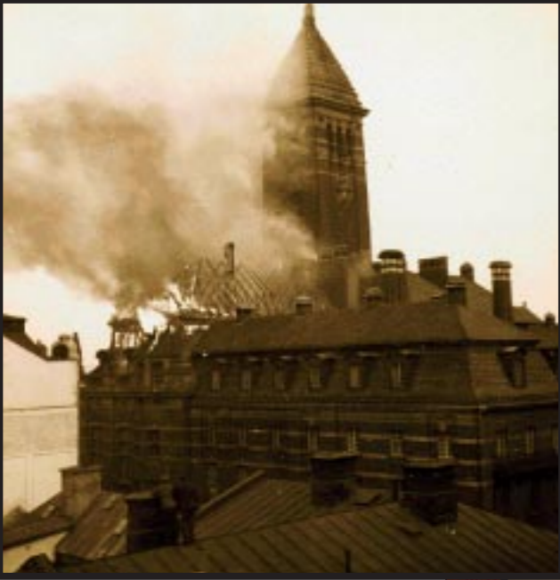
När brandkåren kom på plats var västra Rådhusvinden ett flammande eldhav. Branden hade även fått fäste i den översta våningen på västra hushalvan.
