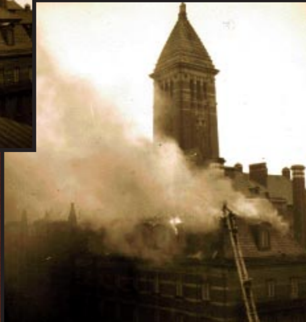
Omkring klockan 14 hade brandkåren fått bukt med branden. Det som slutligen räddade Rådhuset var vindens brandbotten.
