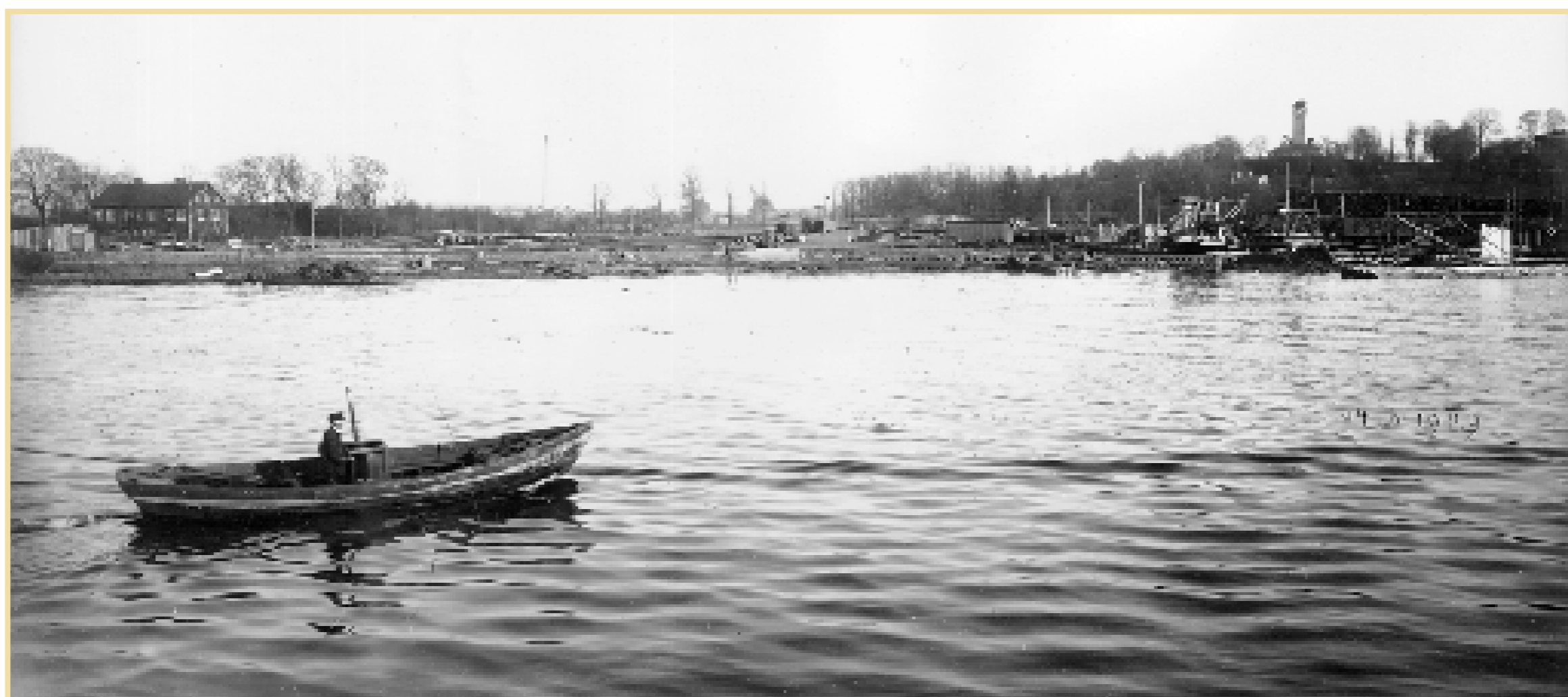
Anledningen till utbyggnaden av den södra kajen var att större fartyg skulle kunna lägga till och att dessa kunde lossas och lastas med tyngre och modernare krananordningar. Till vänster Hospitalsholmens gård och till höger Syltenberget med restaurang Höganloft.
