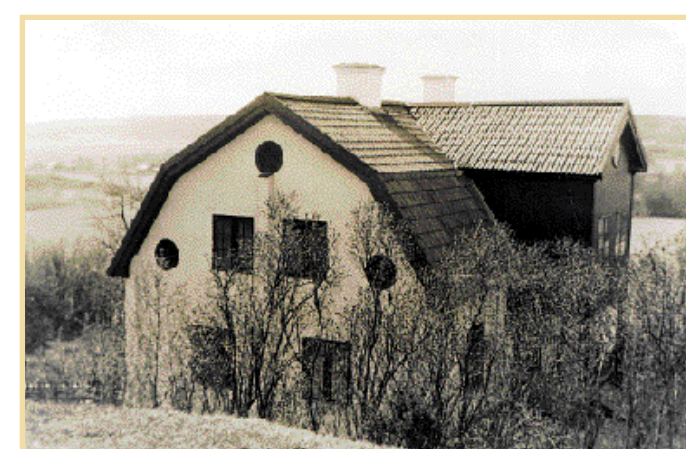
Mangårdsbyggnaden vid Lida ett par år innan den monterades ned och flyttades till Färgargården. Lida gränsade mot gårdar som Ljura, Wallby och Smedby och hade åkrar som sträckte sig till Dagsbergsvägen. Bilden ur Stadsarkivets samlingar.
