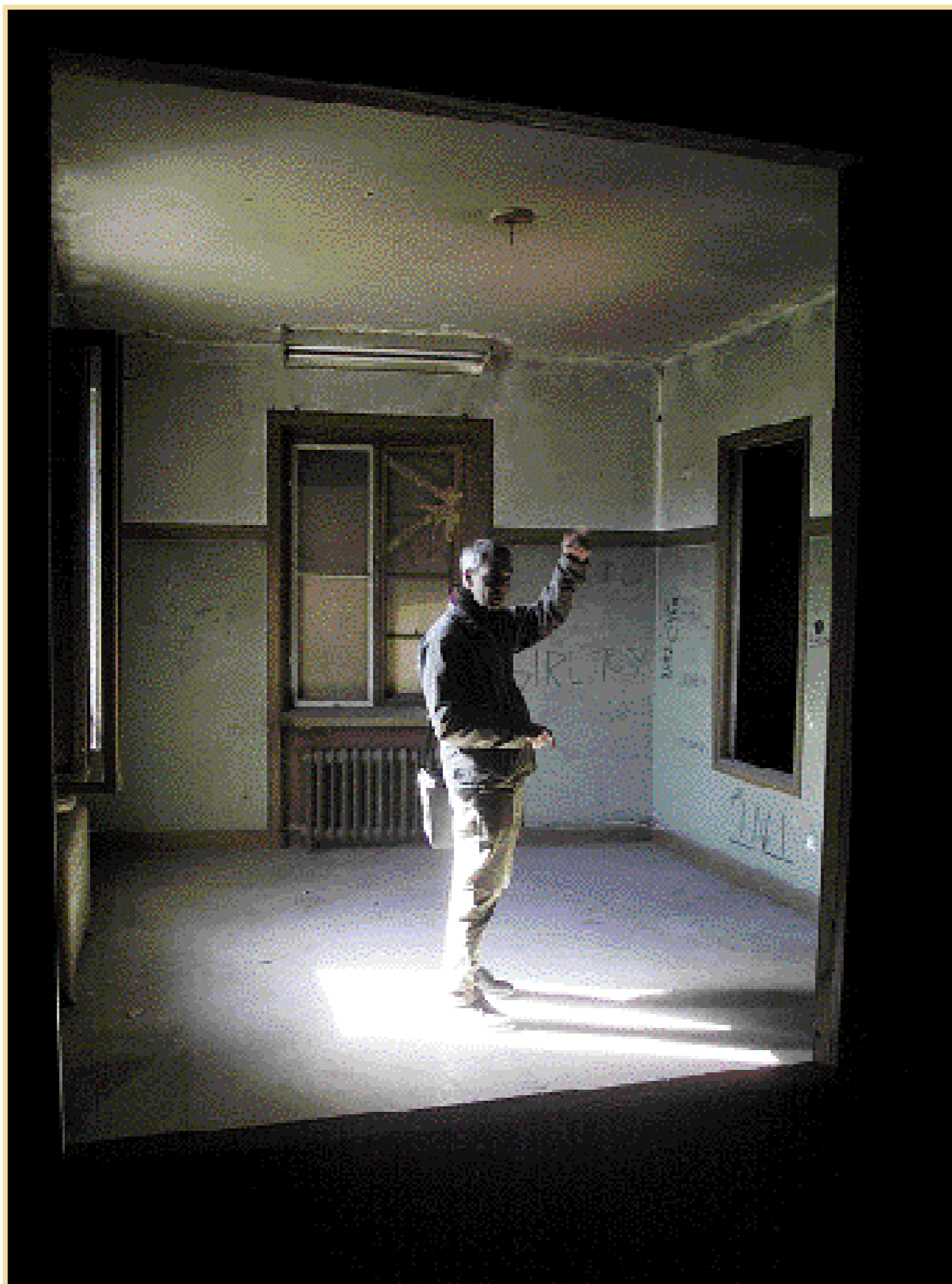
Välbevarat, trots allt. Arkitekten Mats Fredriksson visar upp ett av rummen i kontorsdelen till Ståhlboms silo. Och hela byggnaden kommer troligen att förvandlas till just kontor.
