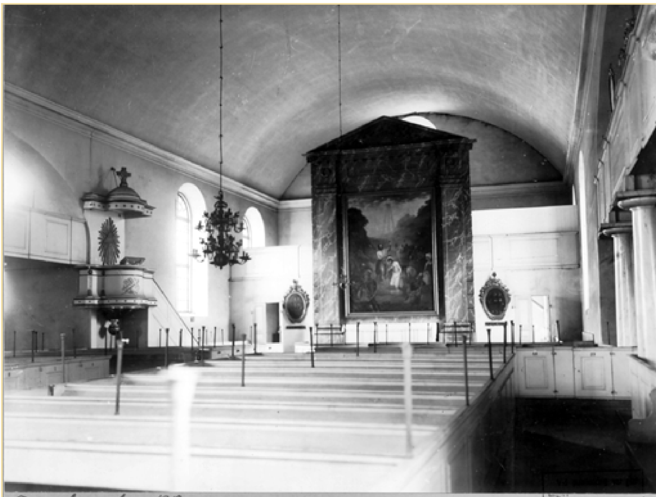
Landskyrkan S:t Johannes innan ombyggnaden 1912. Altartavlan är en kopia av den som konstnären Pehr Hörberg målade och som skänktes till kyrkan i slutet av 1700-talet av redaren och brukspatronen Christian Eberstein. Bilden ur Stadsarkivets samlingar.
