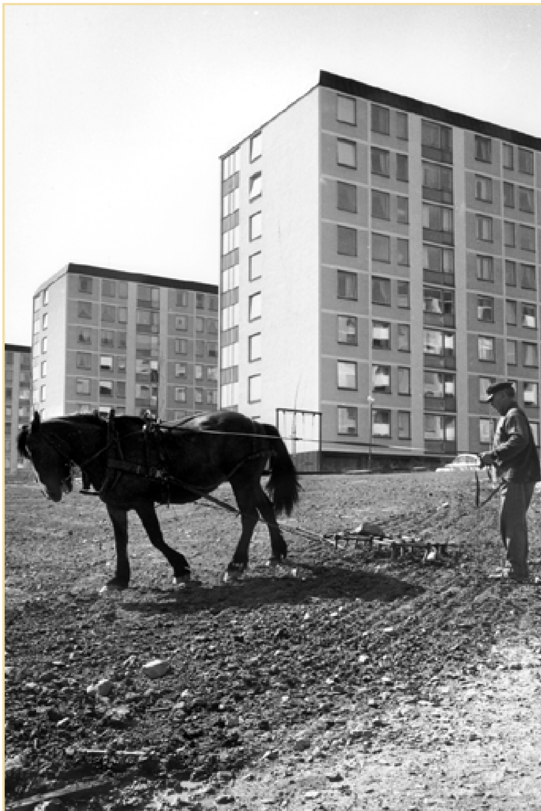
Gammalt och nytt. Den nyuppförda bebyggelsen längs Bäckgatan står i stark kontrast mot mannen och hästen. De senare är i full färd med att ställa i ordning bäckravinerna.
