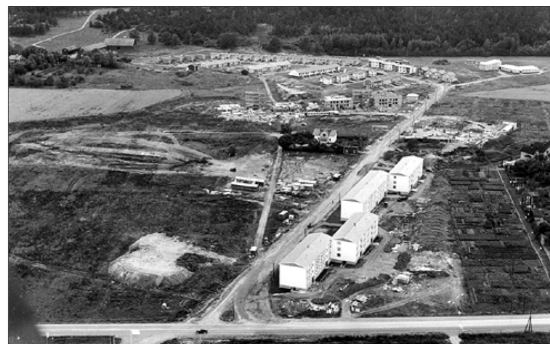
Samma område, men ett halvår senare. De första husen vid det som ska bli Bäckgatan håller på att uppföras. Där bakom ses de radhuslängor vid Vrinnevigatan som uppfördes av privata byggherrar. Därefter Vrinnevi gård.
