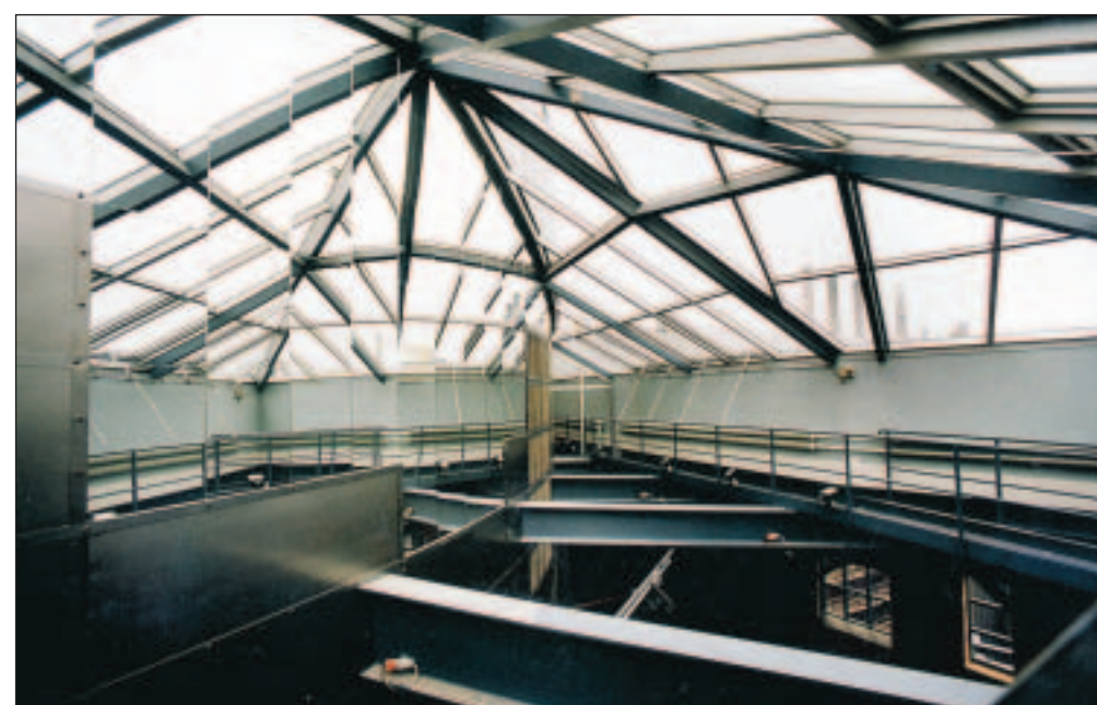
Invändigt i Louis De Geer handlade det mycket om stora ytor av glas om med bärande stålbjälkar. Arkivbild: INGVAR ANEHED
