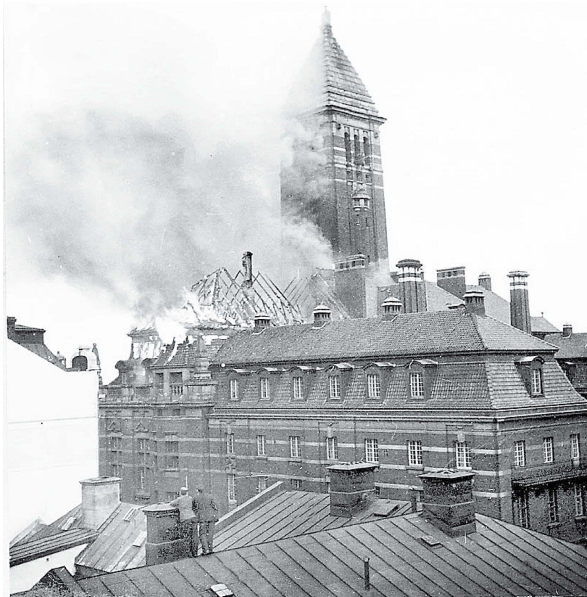
Rådhusbranden 1942, där den västra Rådhusvinden var ett flammande eldhav. Och där Pehr Hörbergs altartavla gick förlorad.
